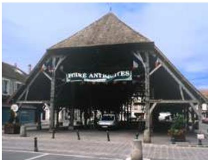
La Halle exposée nord-sud, longue de 46 m, large de 16 m et haute de haute de 13 m, couvre une surface totale de 730 m<sup>2</sup>.
